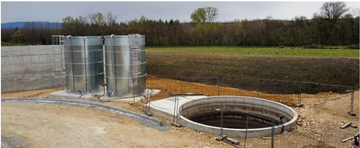
Figure 4: Préfosses aériennes (à gauche) et préfosse enterrée (à droite)
