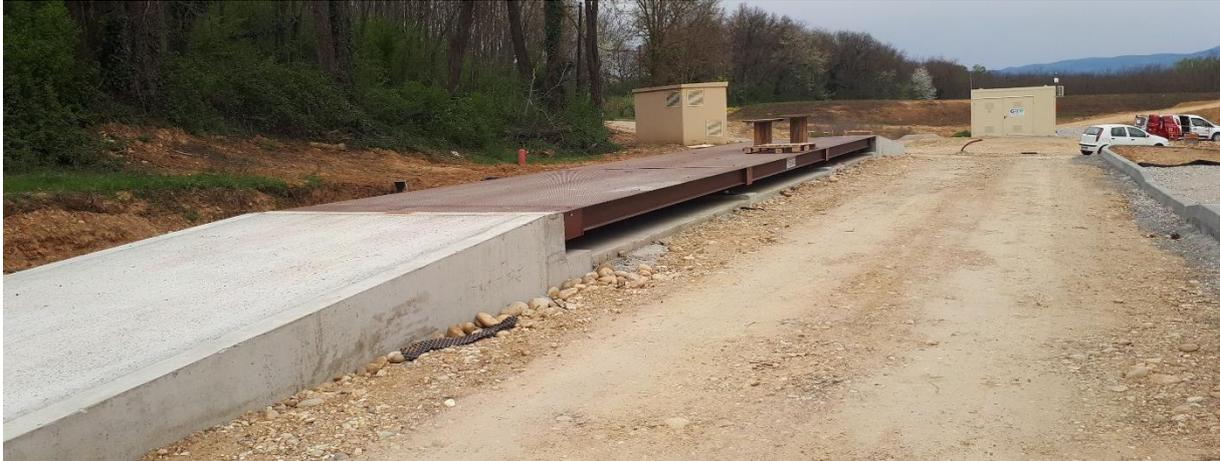
Figure 2: Entrée du site (en arrière-plan) et pont-basculé (en premier plan) de la SAS METHA VAL D'OR
