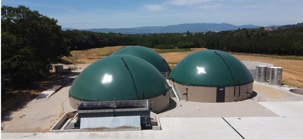
Figure 5 : Photographie d'une trémie d'incorporation (à gauche) et des cuves de digestion surmontées de leurs gazomètres (arrière-plan)
