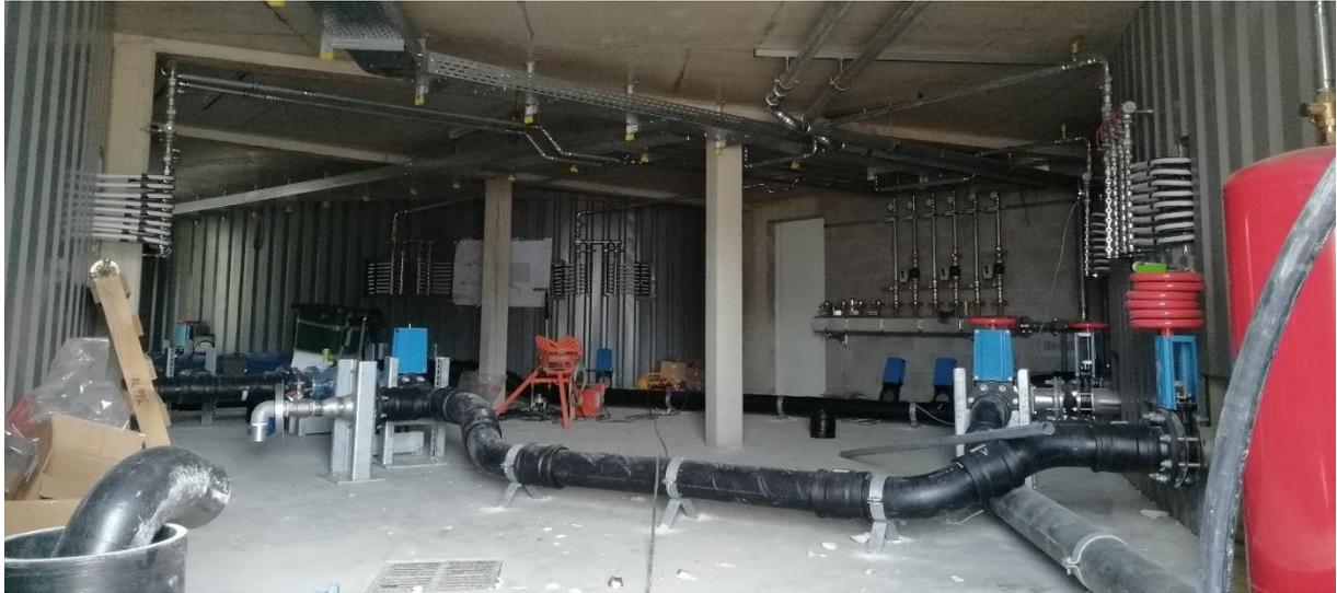
Figure 7 : Pompe entre le digesteur et post-digesteur, dans un local intermédiaire
