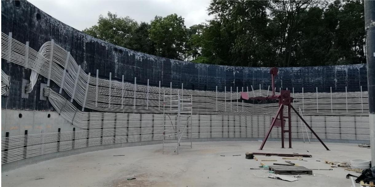
Figure 6 : L'intérieur d'un digesteur avec le système de chauffage et de brassage
